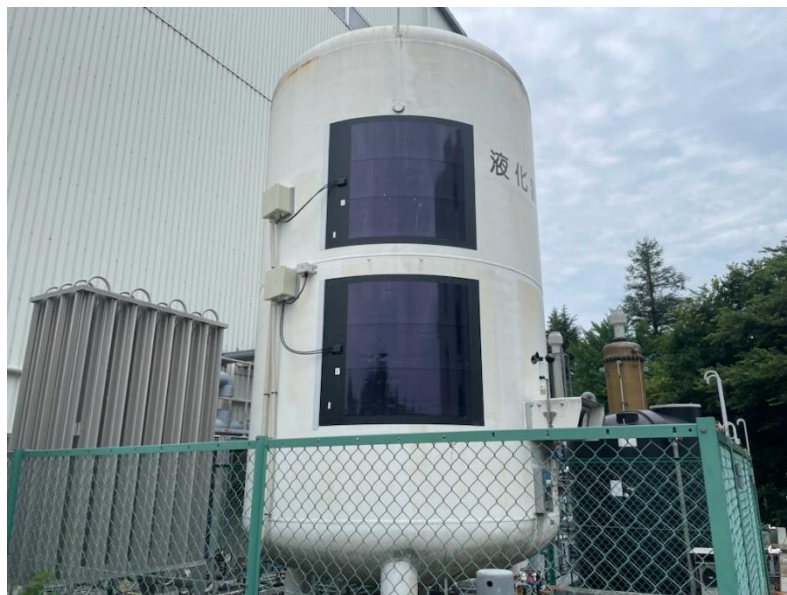
実証実験の様子（タンク壁面②）
