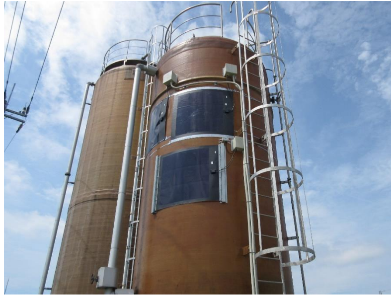
実証実験の様子（タンク壁面①）
