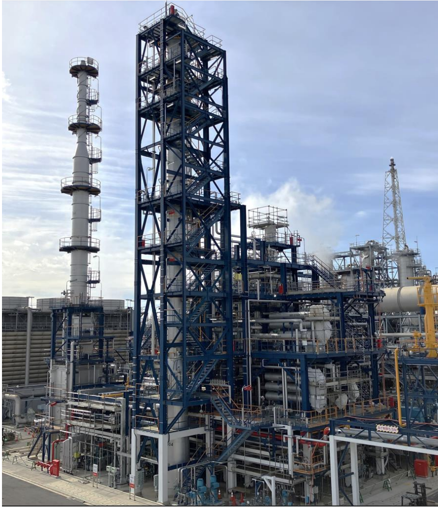
完工した SAF 製造設備（2024 年 12 月撮影）
