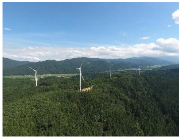
鶴ヶ峰風力発電所
