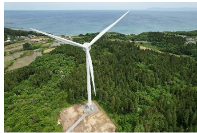
風の杜おが風力発電所
