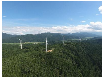
鶴ヶ峰風力発電所
