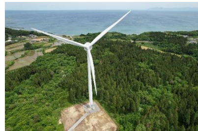
風の杜おが風力発電所
