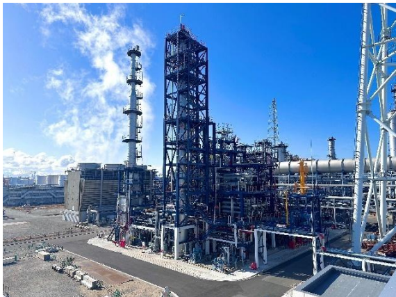
完工した SAF 製造装置
