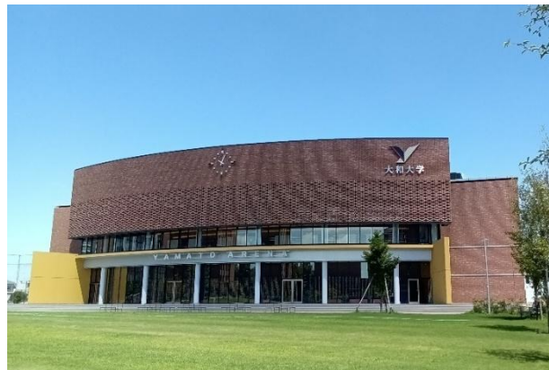
大和アリーナ（大和大学構内）
