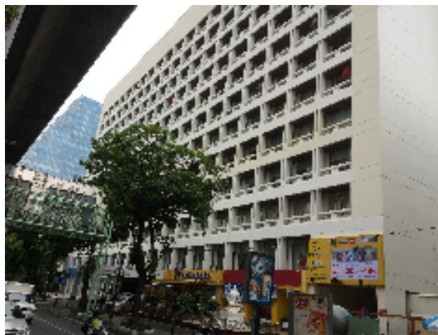
KES 入居ビル外観
