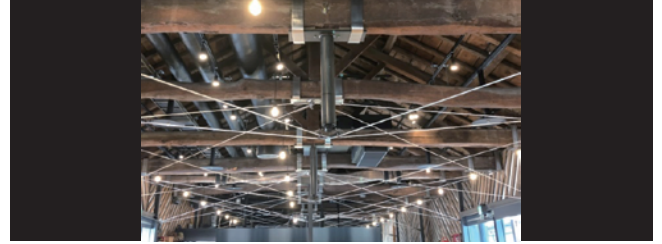
“カボコーマストランドロッド”を使用した水平ブレース事例
