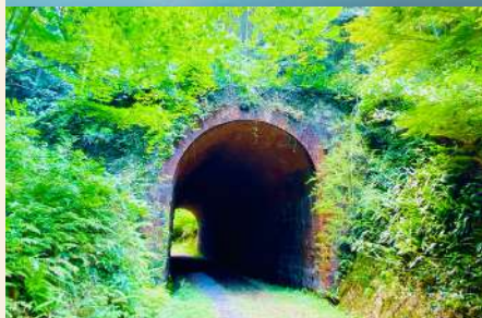
春は桜もきれいな大柵トンネル。
