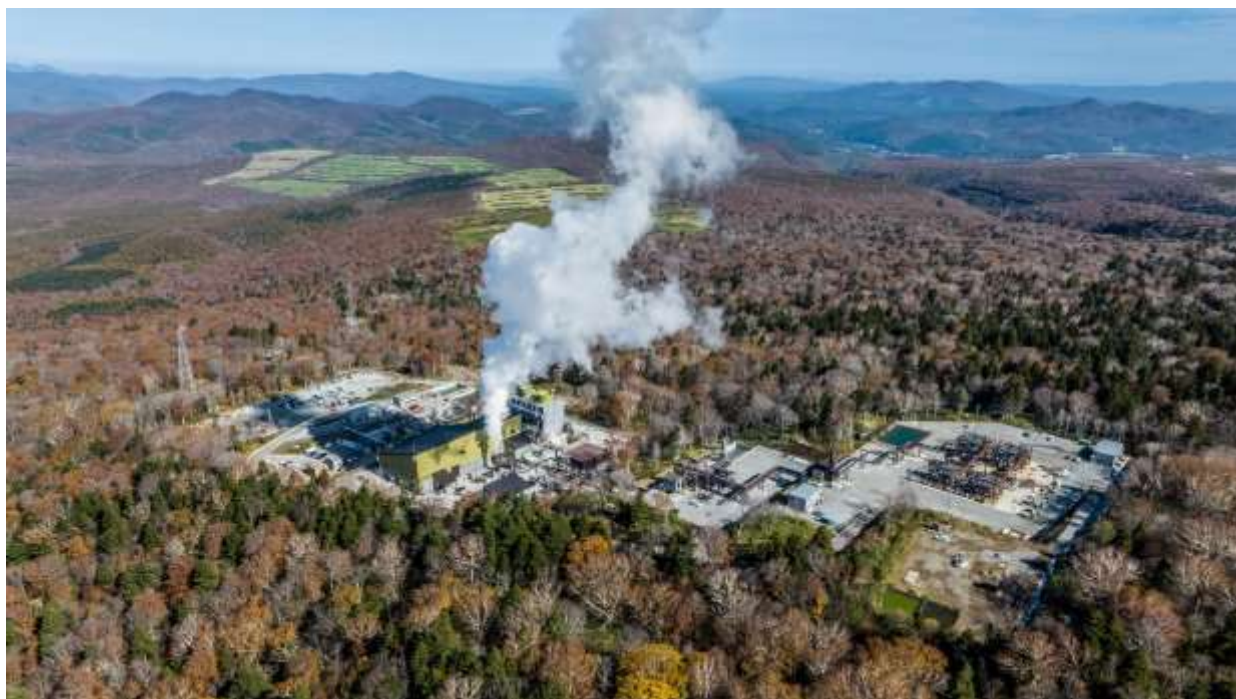
安比地熱発電所全景(提供: 安比地熱株式会社)
