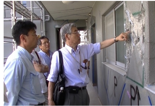
復旧工事の指導を行う様子
