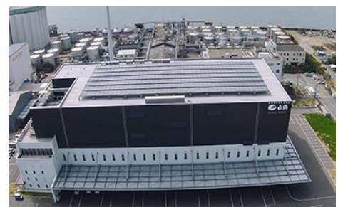
< 灘魚崎工場屋上の太陽光パネル >
