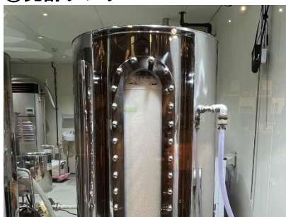
④発酵タンク
