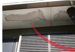
サーモカメラによる漏水部分の確認
