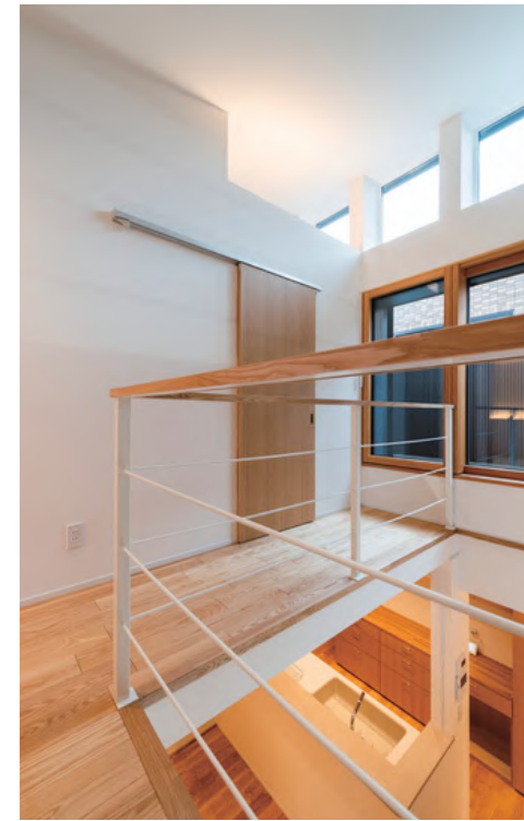
室内の空気と湿気の通り道を考え、湿気がこもりやすい洗面室の入り口上部はオープンにした
