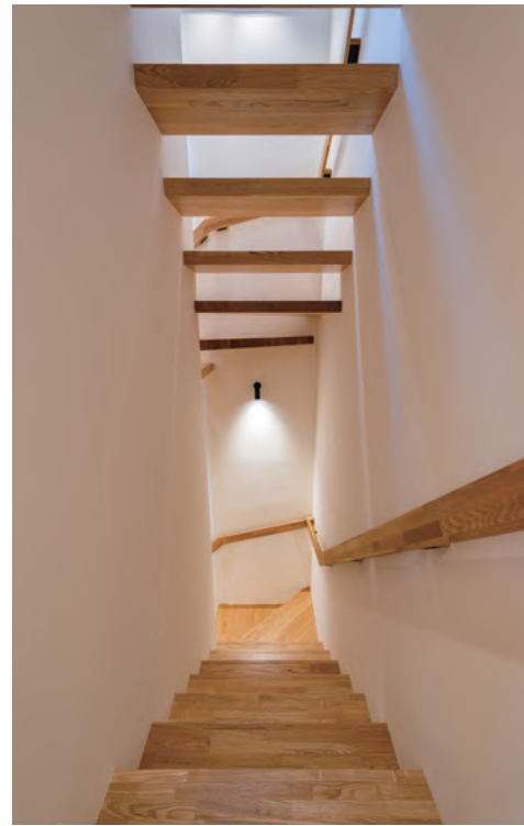
光が差し込むスリット階段。蹴込板がないため、視界を遮らず開放感が得られる。壁・天井は漆喰で仕上げた
