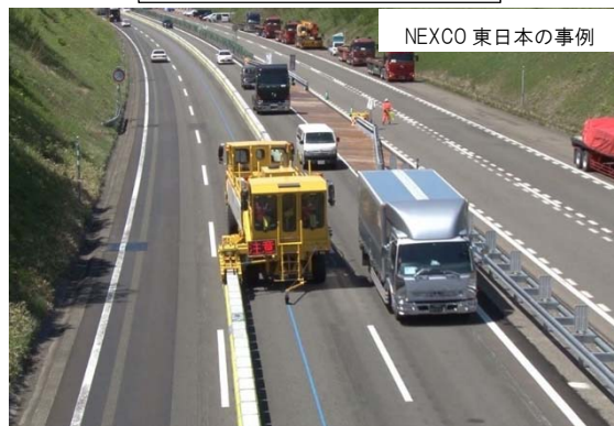
<防護柵切替状況>
