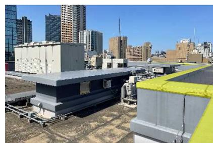
設備機器が多い屋上部に対して、笠木の上(写真黄色部分)を太陽光パネルの設置スペースとして有効活用
