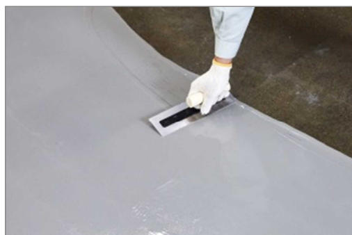
施工時の様子
