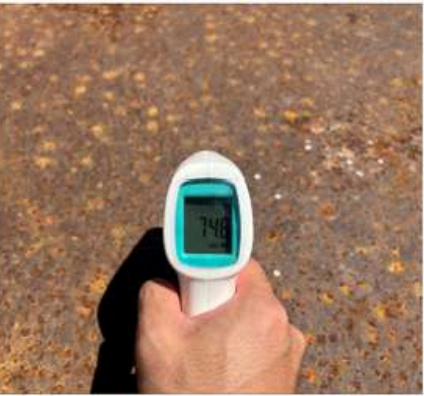
【表面】左：敷鉄板、右：CLT 敷板
