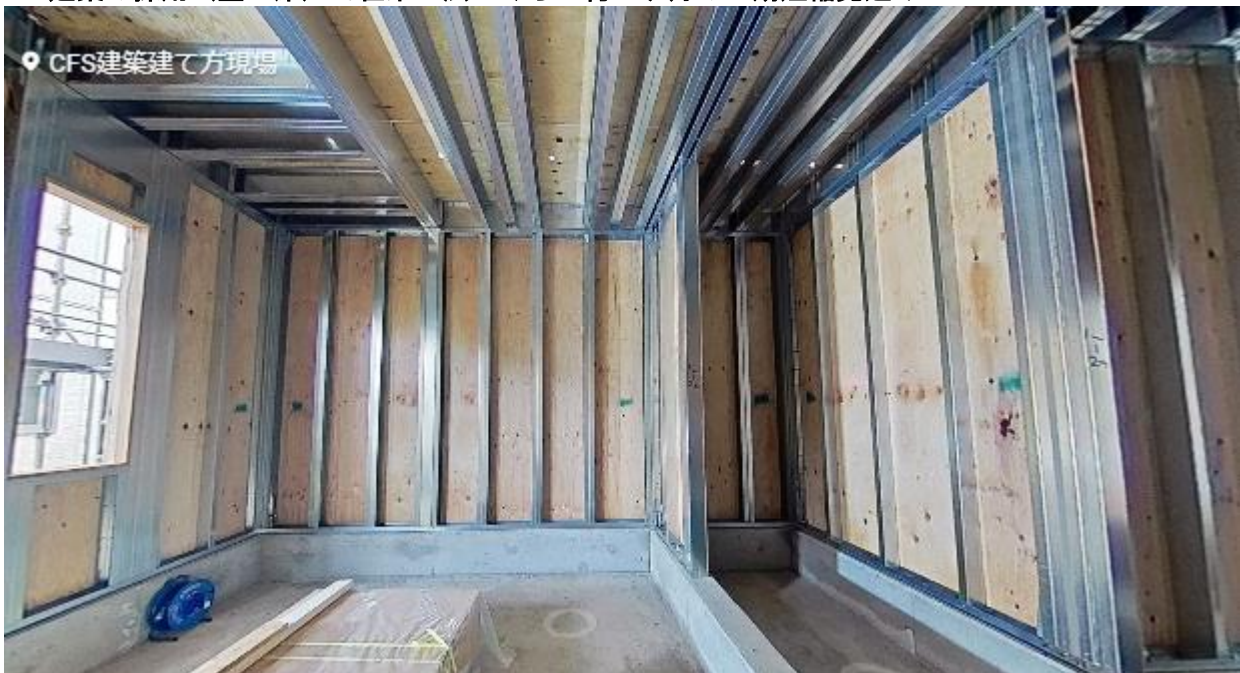
■CFS 建築のイメージ（一般社団法人 日本 CFS 建築協会のウェブサイトから）
