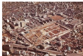
1973年12月 構築物が取り壊され、整地工事がなされた東京拘置所跡地
