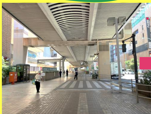
普段の高架下通路の様子
