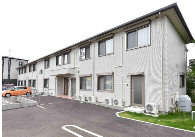
「ナーシングホームしんかわテラス」 全31戸(外観)
