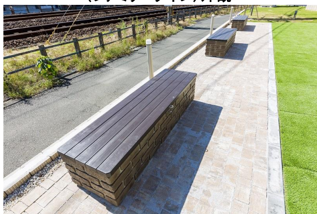
敷地内に設置された防災ベンチ
