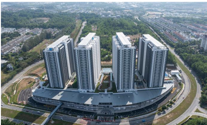
マンション外観(空撮)
