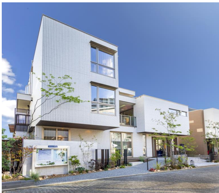
光触媒タイル「キラテック」採用の外壁は12年前の建築当初のまま美しさを保つ
