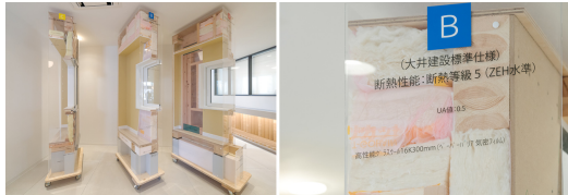
戸建て在来工法／年代別断熱・構造模型
