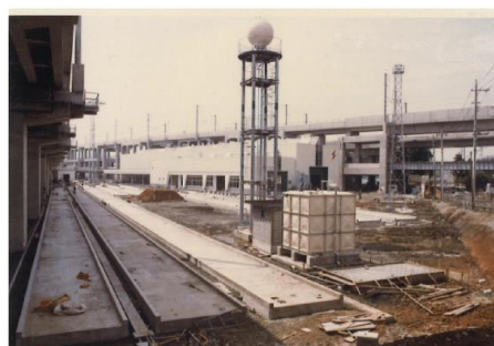
留置線建設風景
