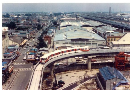
大宮駅を発車してループ線を走行する （JACKビル建設中）
