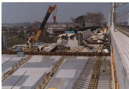
小針駅（仮称・現内宿駅）建設風景
