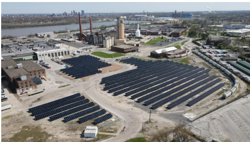
(太陽電池パネルが設置されたロスフォード工場)
