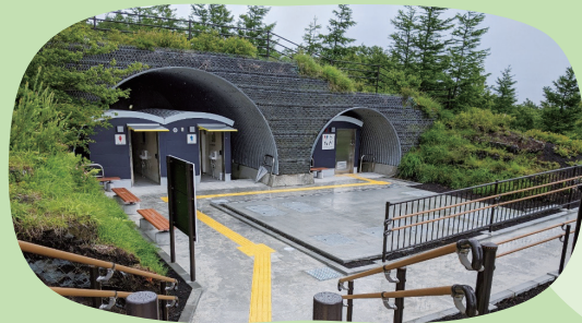
富士山御殿場口新五合目公衆トイレ（静岡県御殿場市）の改築など
