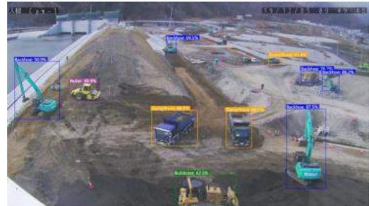
AIによるダンプおよび建機の識別結果
