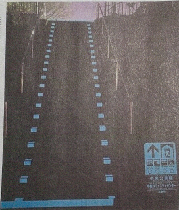
蓄光塗装を施した誘導標識と避難階段。日光を吸収して光り、日没後も階段の位置が分かる(高輝度蓄光塗料推進協会提供)
