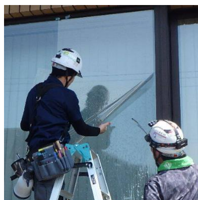
写真左：幌加内町役場庁舎 写真右：放射冷却素材「Radi-Cool」フィルム施工の様子
