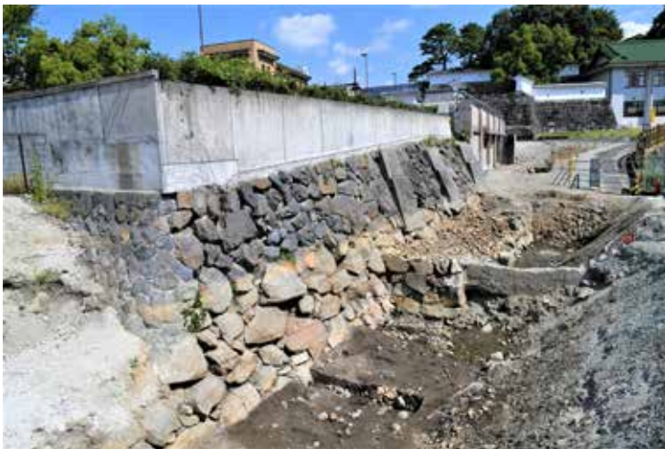
発掘された内堀の石垣
