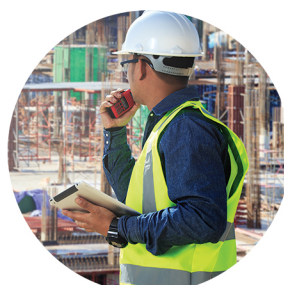
工事現場 Construction Site
