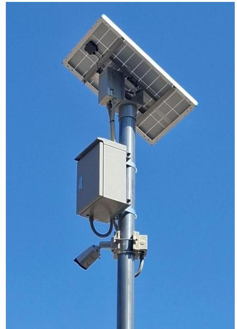
ソーラーパネル・バッテリーボックス・LTE 監視カメラの設置例
