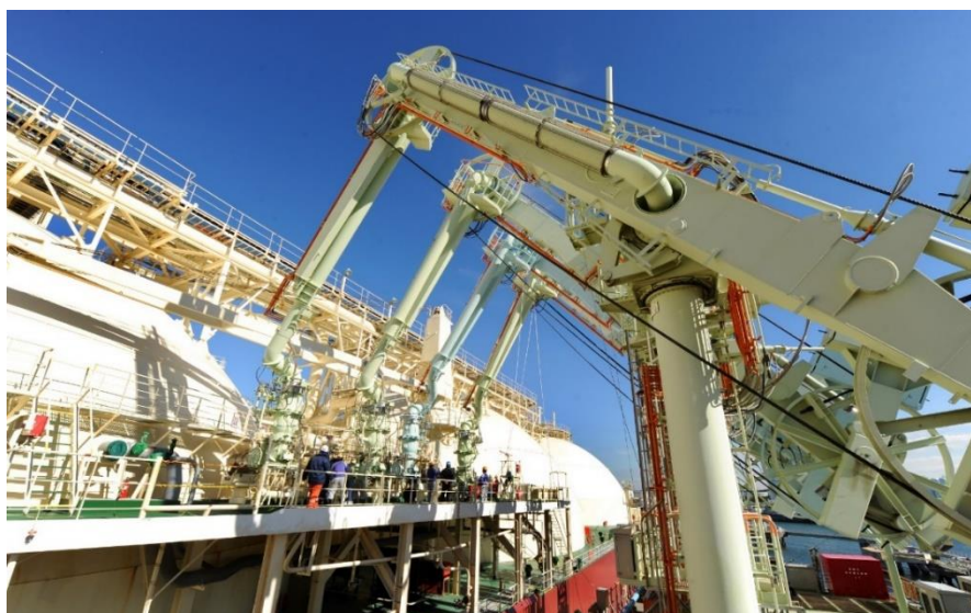
TBG 製 LNG ローディングアーム
